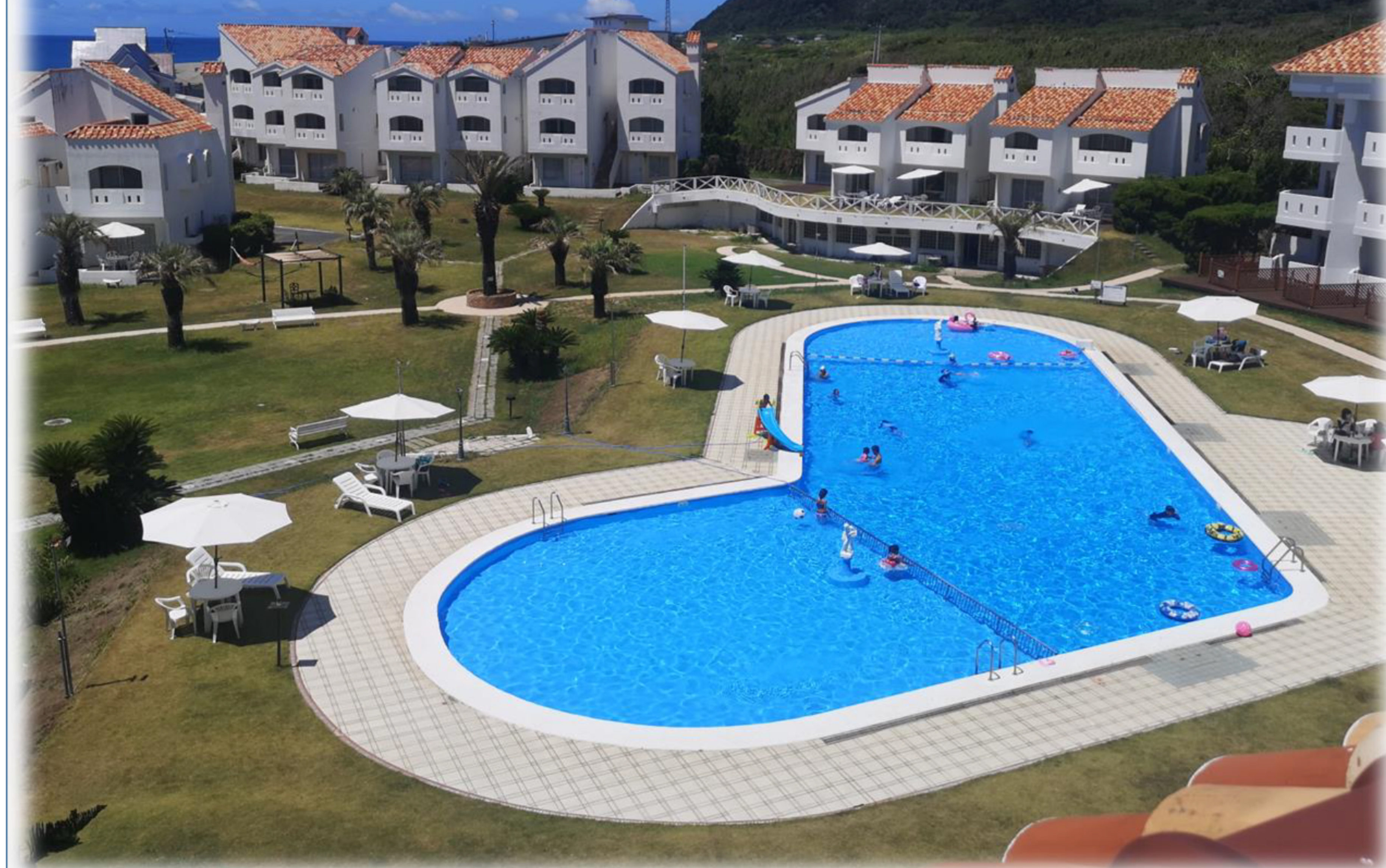
セントラルプール
